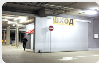
Shopping center «Outleto», Minsk Automatic sliding fire gates «FireDoors» Ei60
