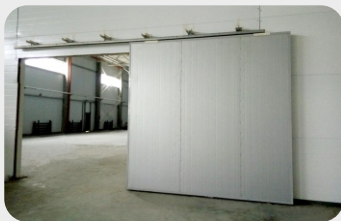
Plant «Amkodor-Elastomer», Minsk region Automatic sliding fire gates «FireDoors» Ei60
