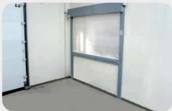
Garage of the «Belarusbank», Minsk Automatic fire curtains «FireDoors» Ei120
