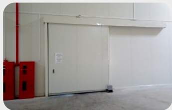
Plant «Onega Plus», Minsk district Automatic sliding fire gates «FireDoors» Ei60
