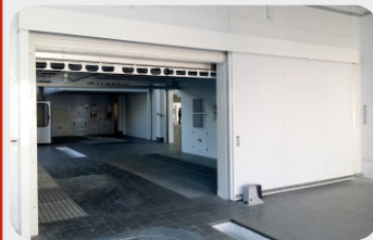
Car center «Renault», Minsk Automatic sliding fire gates «FireDoors» Ei60
