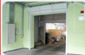
Factory «BelWoodDoors», Minsk Automatic fire curtains «FireDoors» Ei120
