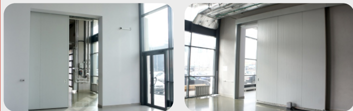
Car center «Parade Auto», Minsk Automatic sliding fire gates «FireDoors» Ei60
