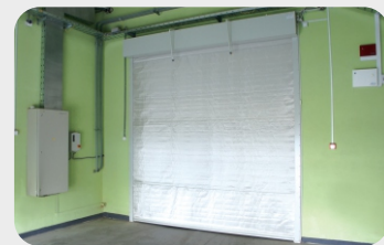
Factory «BelWoodDoors», Minsk Automatic fire curtains «FireDoors» Ei120
