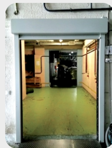
Plant «BellaPak», Minsk Automatic fire curtains «FireDoors» Ei120
