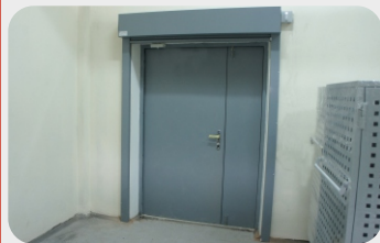
Garage of the «Belarusbank», Minsk Automatic fire curtains «FireDoors» Ei120
