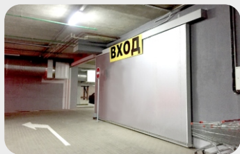
Shopping center «Outleto», Minsk Automatic sliding fire gates «FireDoors» Ei60
