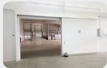
Plant «FerroliBel», Minsk district Automatic sliding fire gates «FireDoors» Ei60
