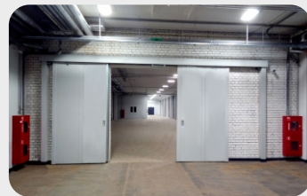
Auto parts warehouse «MotorLand», Minsk Automatic sliding fire gates «FireDoors» Ei60
