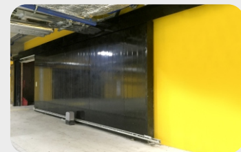
Shopping center «Gallery Minsk», Minsk Automatic sliding fire gates «FireDoors» Ei60
