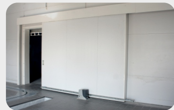
Car center «Renault», Minsk Automatic sliding fire gates «FireDoors» Ei60
