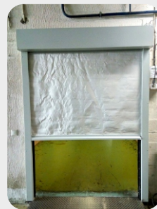
Plant «BellaPak», Minsk Automatic fire curtains «FireDoors» Ei120
