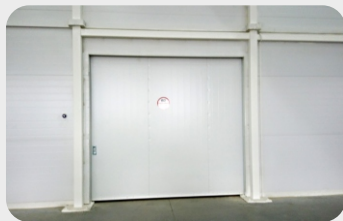
Plant «FerroliBel», Minsk district Automatic sliding fire gates «FireDoors» Ei60
