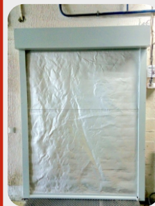
Plant «BellaPak», Minsk Automatic fire curtains «FireDoors» Ei120
